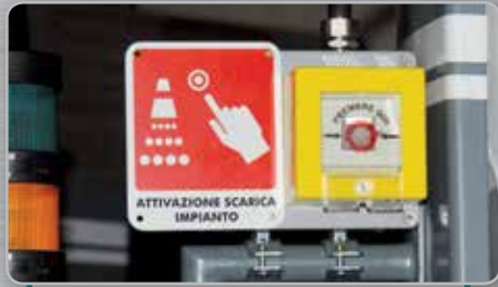
Système d'extinction d'incendie Dispositivo anti-incendio
